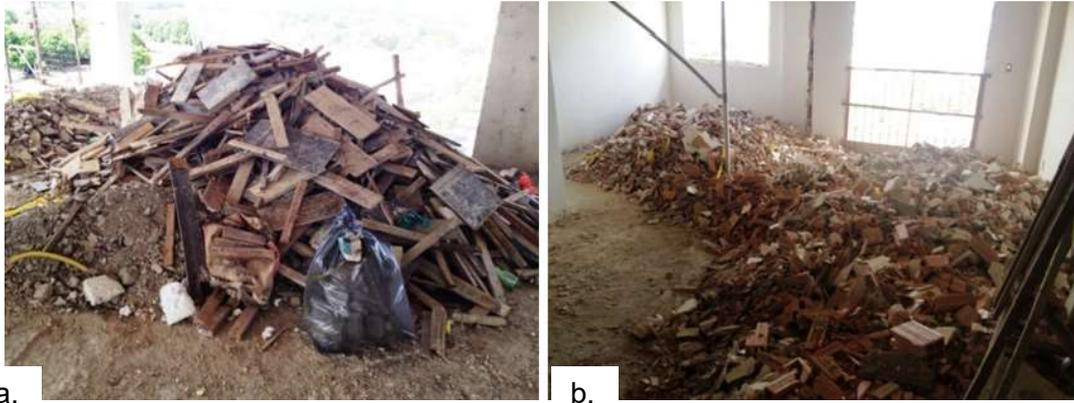
a.e b. Depósito pontuais de RCC em pavimentos térreo e tipo, em duas das obras investigadas. Fonte: A autora.
